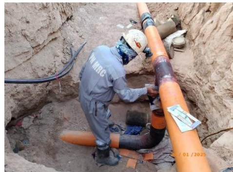
(ข) การตรวจสอบรอยเชื่อมแบบไม่ทำลาย (Non Destructive Testing: NDT)
