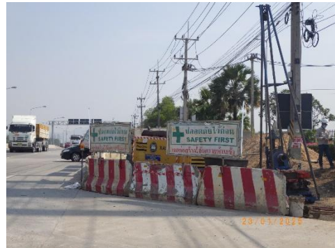
รูปที่ 2-37 การกั้นเขตพื้นที่บริเวณที่มีการติดตั้งเครื่องจักร เครื่องยนต์ และพื้นที่สำหรับจัดวางอุปกรณ์และเครื่องมือต่าง ๆ
