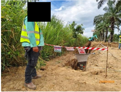
(ค) การติดตั้งป้ายเตือนแสดงเขตพื้นที่ทำการเชื่อมต่อ
