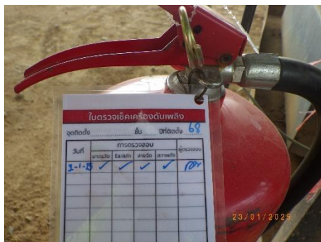
รูปที่ 2-41 ถังดับเพลิงบริเวณพื้นที่ปฏิบัติงาน และแบบบันทึกการตรวจสอบสภาพถังดับเพลิง
