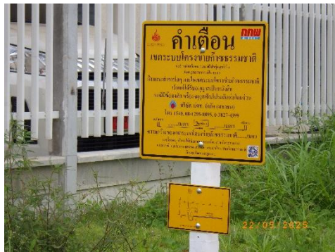
รูปที่ 2-52 ป้ายเตือนแสดงตำแหน่งแนววางท่อส่งก๊าซธรรมชาติ และเบอร์ตอร์ทพท์ในการแจ้งเหตุฉุกเฉิน
