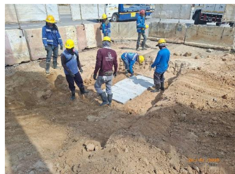
แผ่นคอนกรีตเหนือแนวท่อบริเวณตำแหน่งที่เป็นจุดเชื่อมต่อ (Tie-in)
