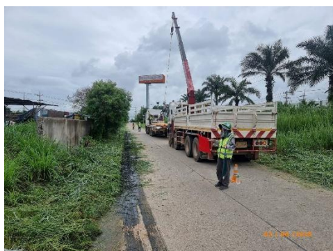
รูปที่ 2-49 การตรวจสอบระบบสาธารณูปโภคใต้ดินบริเวณพื้นที่ก่อสร้างของโครงการ
