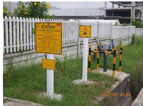
รูปที่ 2-52 ป้ายเตือนแสดงตำแหน่งแนววางท่อส่งก๊าซธรรมชาติ และเบอร์ตอร์ทพท์ในการแจ้งเหตุฉุกเฉิน
